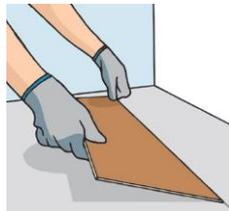
Régua - Para marcar o eixo, tome como base a parede de início da instalação, conforme paginação. Meça a largura da régua e trace uma linha paralela à parede, no mínimo 1cm menor que essa largura.
