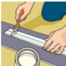
c. Aplique o adesivo de duplo contato sem toluol nas paredes e nas barras. Aguarde o adesivo secar por aproximadamente 15 minutos. Caso preferir, pode utilizar fita VHB ou cola para rodapé para essa fixação.
