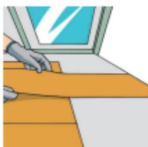
25.5. Distribua régua soltas sobre as últimas coladas (próximas às paredes), encoste-as na parede e com um estilete copie os recortes. Dobre a régua para trás, corte a sobra com o estilete golfinho e encaixe no espaço correto. Repita este procedimento ao longo de todas as paredes.
